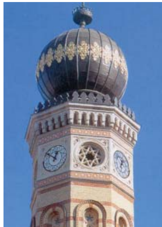
A budapesti zsinagóga épülete
